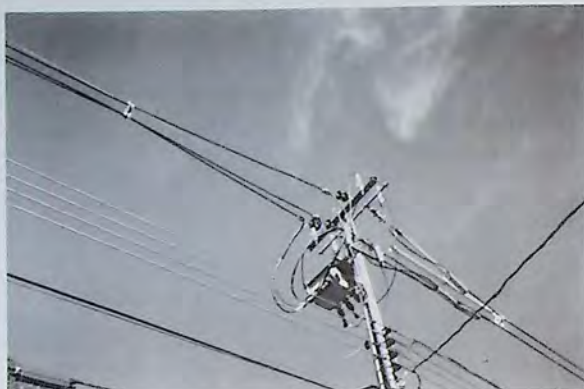
Detalhe da rede compacta com cabo coberto
