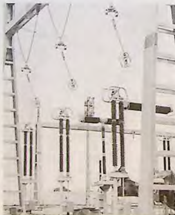
Seccionador semi-pantográfico tipo LAV
