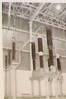
Capa: Equipamentos da subestação compacta de 145 kV - Foto: Francisco Emolo
